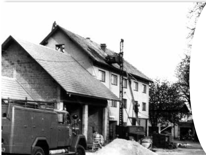
Gradnja prizidka in obnova gasilskega doma 1985/86.
