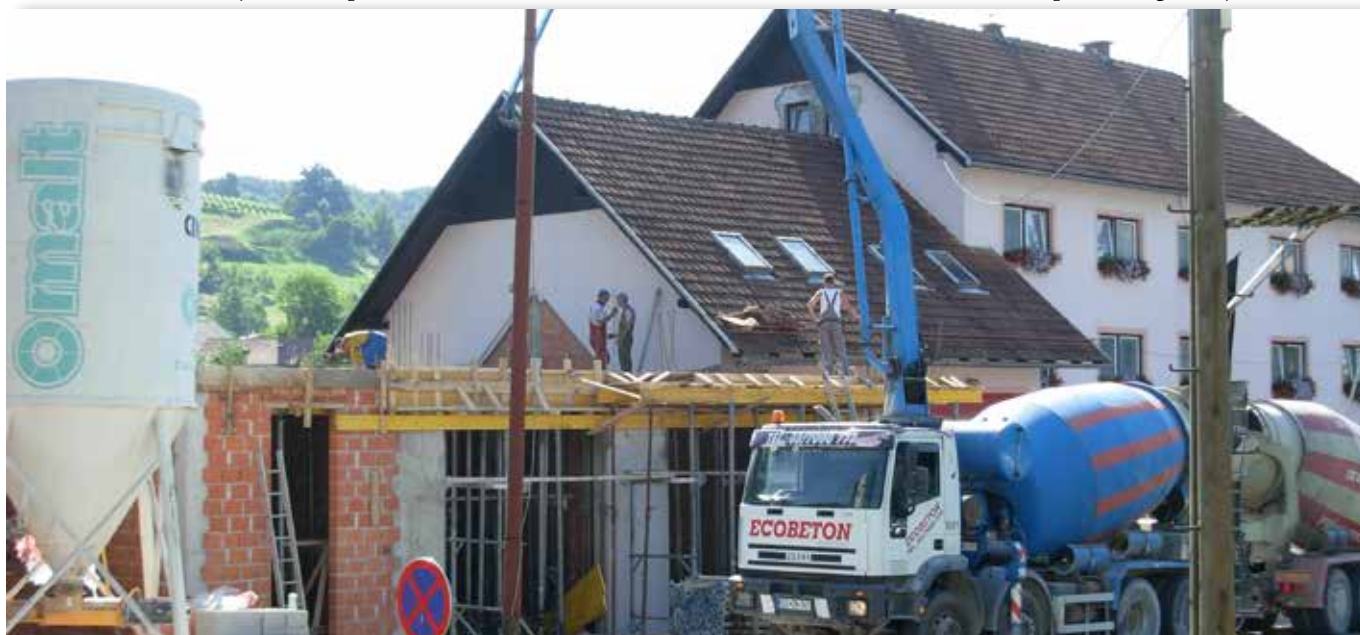
Zreče; 24. 6. 2008, začetek gradnje prizidka GD Zreče.
