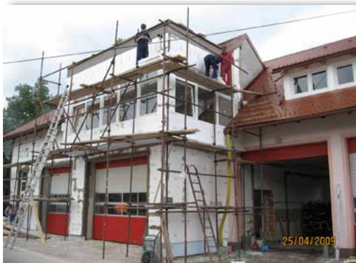
Izdelava fasade na prizidku GD.
